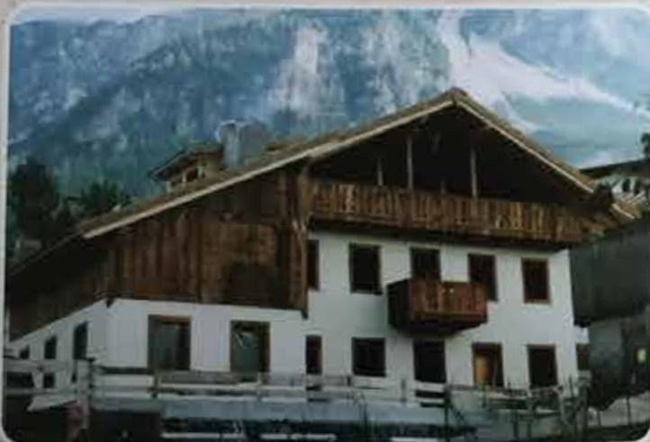
Casa-laboratorio, S. Vito di Cadore, Belluno (1998). Intonaci esterni realizzati con SANACOLOR 2000 MGN, colore su campione, a effetto dilavato.
