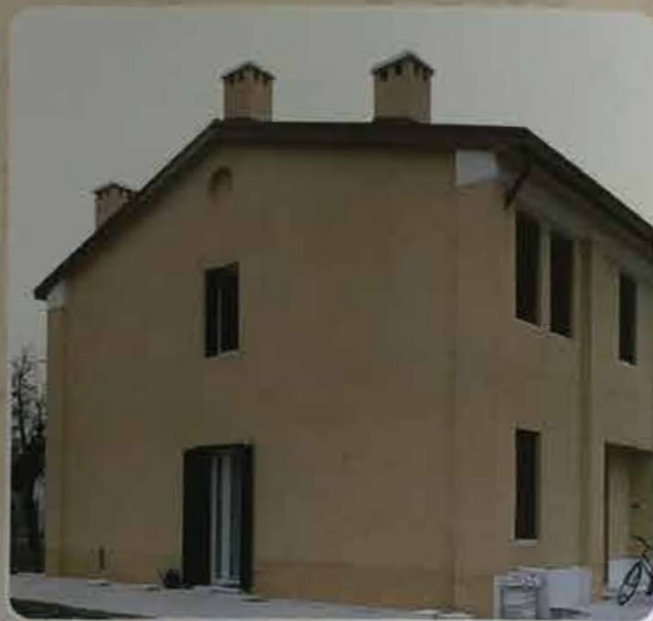
Casa privata a Dueville, Vicenza (1998). Intonaci esterni su muratura in Poroton con RINZAFFO MGN e SANACOLOR 2000 MGN, colore giallo 08.
