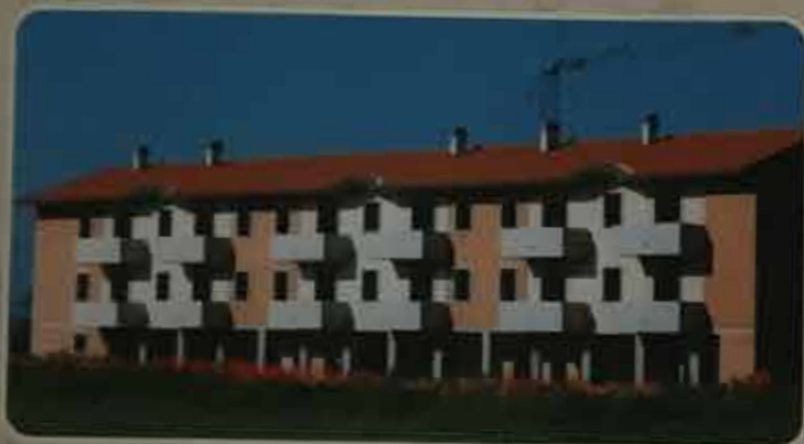
Cantiere I.A.C.P. a Forlimpopoli, Forlì (1998). Intonaci esterni realizzati con RINZAFFO MGN e SANACOLOR 2000 MGN, colore rosa 05.
