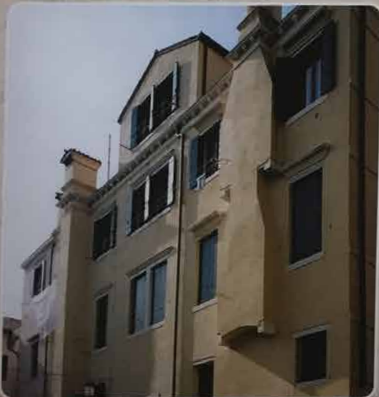
Centro Storico di Chioggia, Venezia (1997). Rifacimento degli intonaci con SANACOLOR 2000 MGN, colore giallo su campione.
