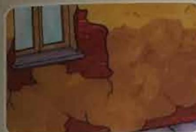
1. Intonaco danneggiato da acqua e sali. Analisi delle cause e rilievo delle quote di risalita dell'umidità.
