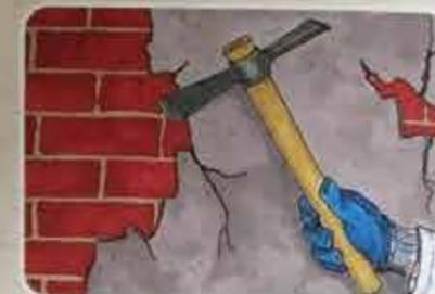
2. Demolizione accurata dell'intonaco ammalorato circa 1 metro sopra la parte degradata; rimozione dei materiali non compatibili.
