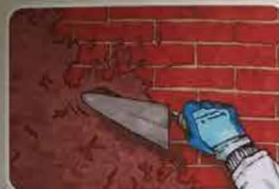
4. Applicare l'intonaco RINZAFFO MGN a copertura totale del supporto, in andamento alla muratura, con spessore minimo di 5 mm.
