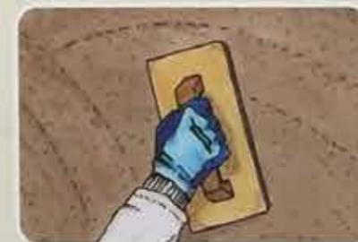
9. Attendere la presa della prima mano ed applicare una seconda mano di Risanamur B80 a finire, livellando la superficie dell'intonaco.
