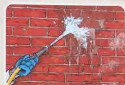
3. Lavaggio accurato della superficie da trattare con getto d'acqua a pressione, al fine di asportare le parti mobili e sali residui in superficie.
