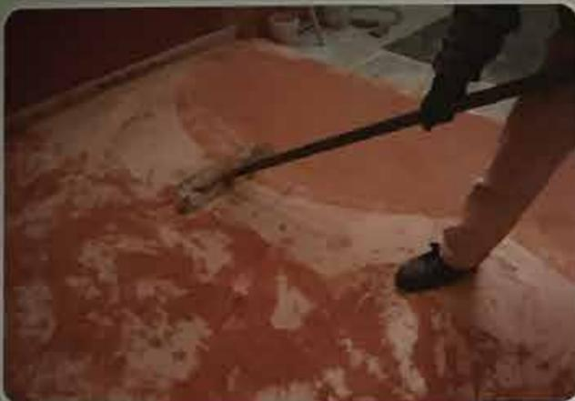
Una volta indurita la parte superficiale del massetto, una veloce raschiatura dello stesso rende planare la superficie eliminando eventuali piccole anomalie di stesura rendendolo pronto alla posa della pavimentazione.
