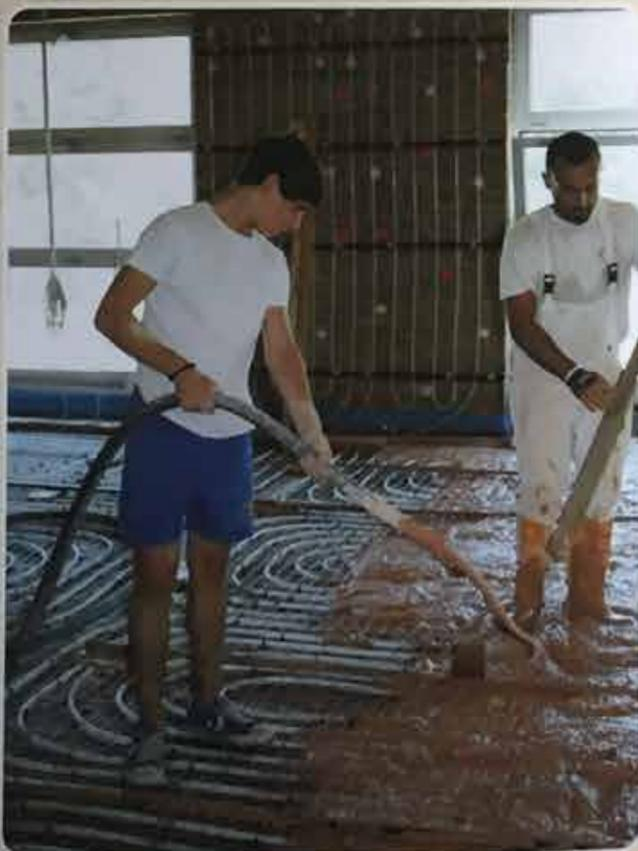
L'estrema facilità di messa in opera che può essere eseguita con macchina intonacatrice.
